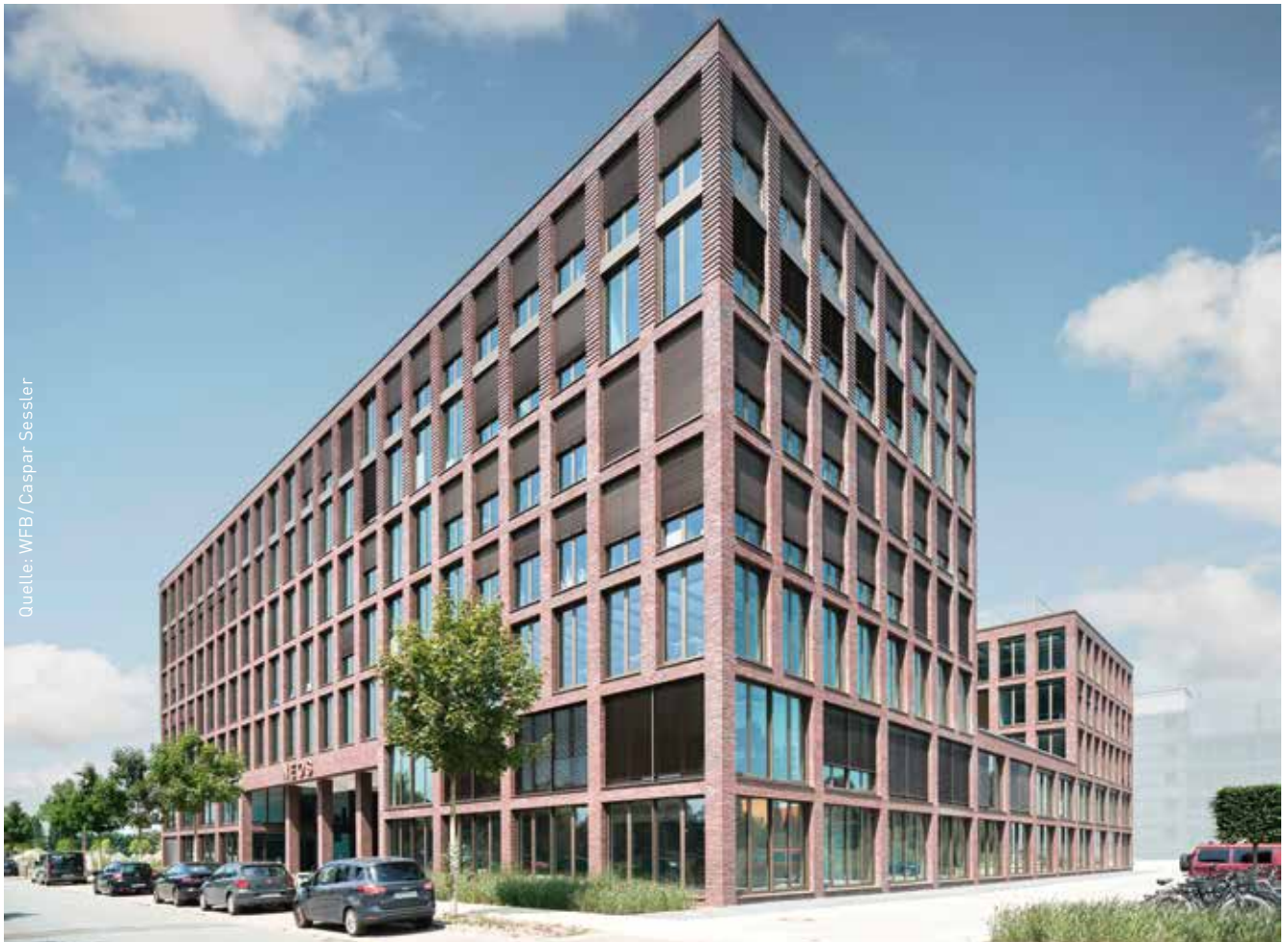
NEOS Gebäude im Technologiepark
